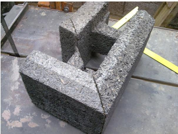
Die so verklebten Schrägschnitte sind nach dem Aushärten in der Lage dem später aufkommenden Betondruck standzuhalten.
