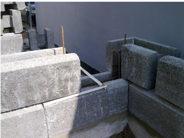
Nach dem Erstellen der ersten Steinschicht wird die erste waagerechte Stahlbewehrungslage in den Wandverfüllraum eingelegt. In den Ecken werden die Winkelleisen über Kreuz ( siehe Bild ) eingelegt. Wenn aus statischer Sicht nicht anders vorgeschrieben, werden zwei 8 mm dicke Stabstahllängen fachgerecht, d.h. mit ca. 60 cm Überdeckung mit dem Folgestabstahl der Horizontalbewehrung eingelegt und mit Bindedraht miteinander verbunden.
