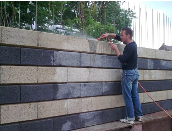
17. Betonreste sofort per harten Wasserstrahl aus dem Steingefüge ausspritzen
