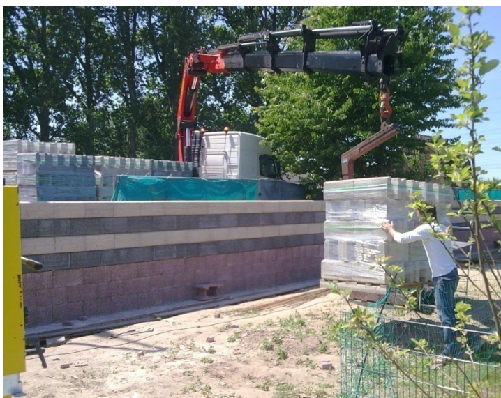
11. Steinlieferung per Kranentladung, falls gewünscht
