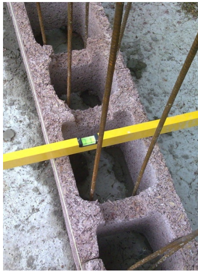
4. Erste Steinreihe mit Anschlussbewehrung exakt ausrichten
