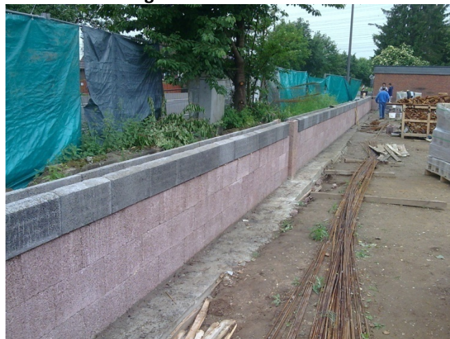
9. Sockelsteinschicht aus Hochbausteinen DMi 25/18
