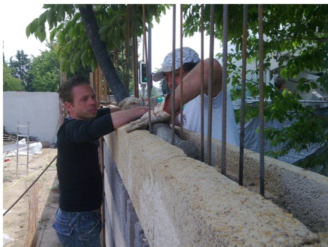
14. Betonverfüllung mit Pumpgestellung
