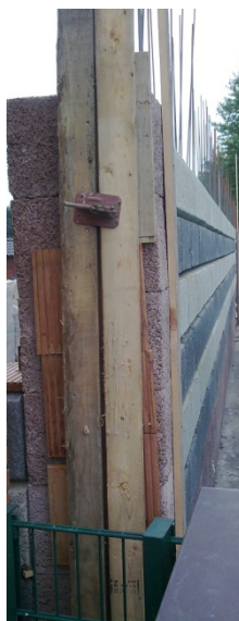
12. Sicherung der Außenwand- Enden
