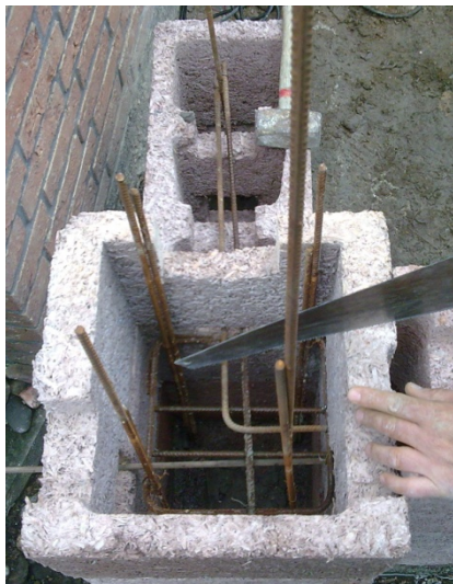
6. Betonverbindungen herstellen
