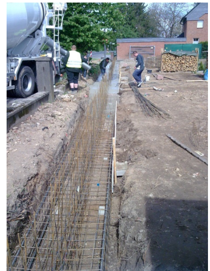
3. Betonieren und verdichten
