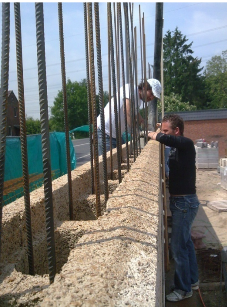
15. Gleichmäßige Betonverteilung
