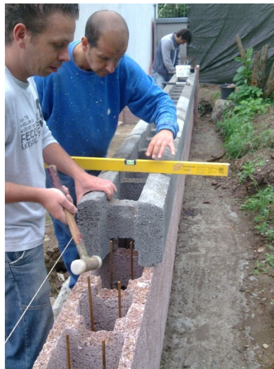
7. Erste Reihe Lärmschutzsteine
