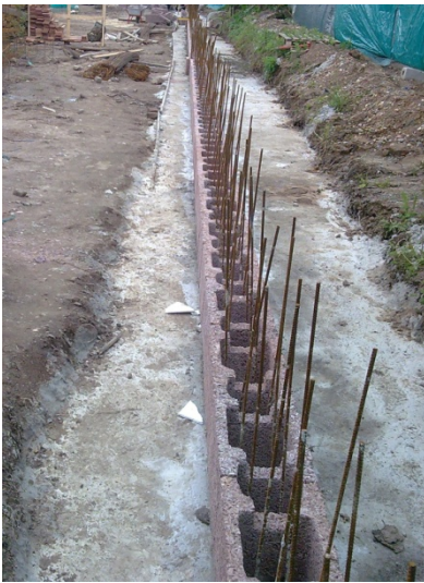
4. Erste Steinreihe mit Anschlussbewehrung exakt ausrichten
