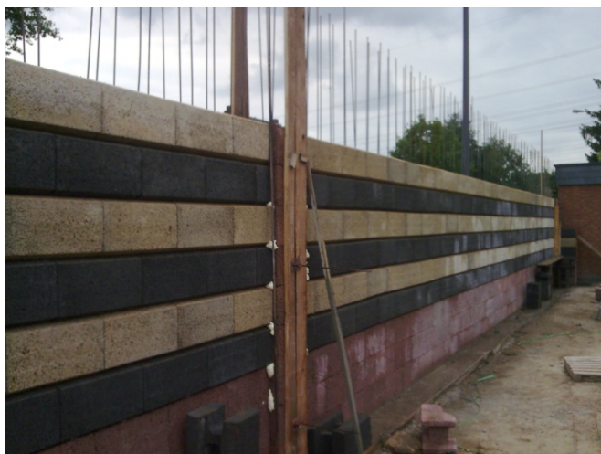
18. Fertigstellung des ersten Bauabschnitt
