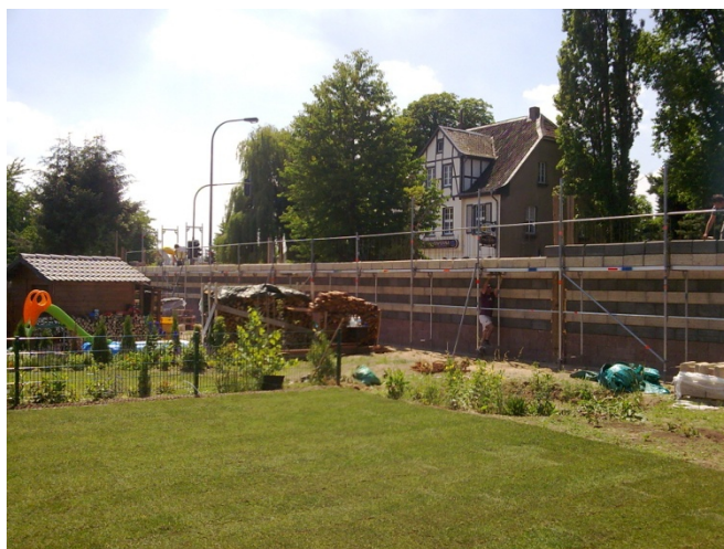
19. Ohne Gerüststellung geht es nicht !
