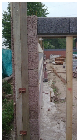
12. Sicherung der Außenwand- Enden
