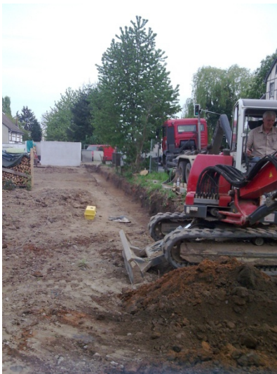
1. Aushub mit Maschinentchnik
