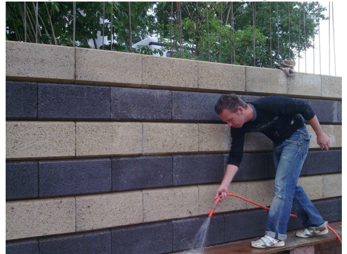
17. Betonreste sofort per harten Wasserstrahl aus dem Steingefüge ausspritzen
