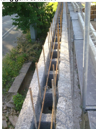
21. Baustahlpositionierung
