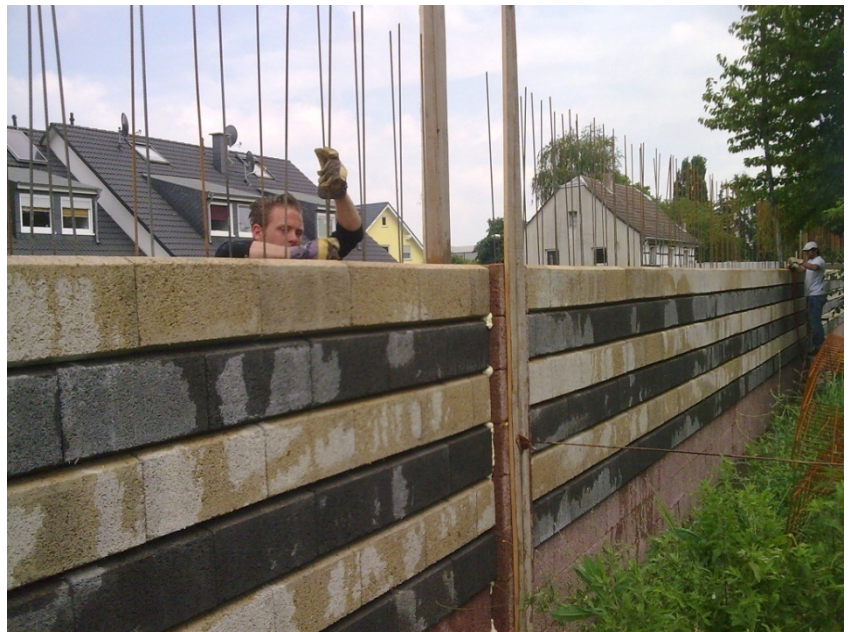
16. Baustahljustierung nach dem ersten Betoniervorgang
