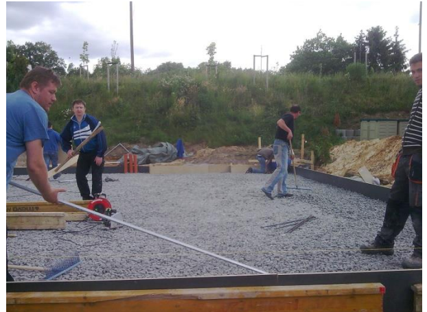
HIER WIRD DIE BODENPLATTE NOCH ABGESCHALT, DIE ENTWICKLUNG SCHREITET BEI UNS VORAN UND WIR MIT IHR WÄHEND BAUEN ANSICH IN DER ENTWICKLUNG SEIT JAHREN SCHON AUF DER STELLE TRITT.
