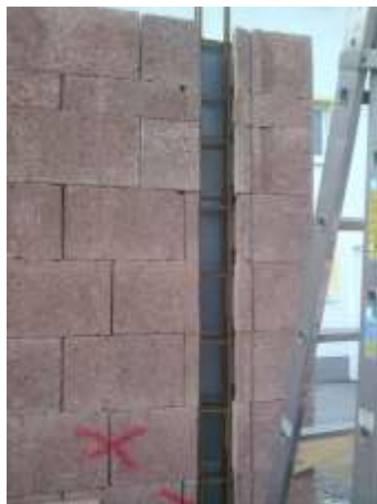
Stahlbetonstütze wandintegriert
