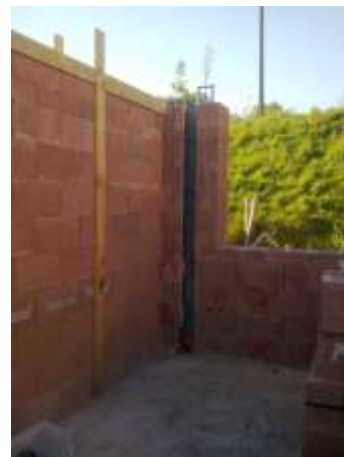
Entwässerungsrohr wandintegriert
