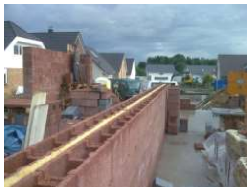
Entwässerungsrohr wandintegriert
