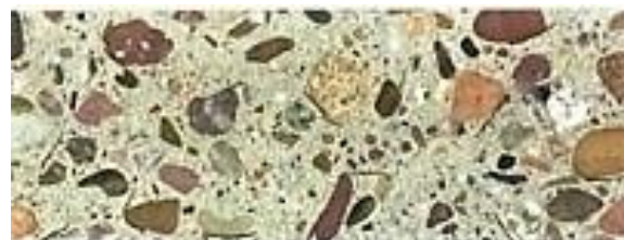
Deutlich verminderte Rissbildung bei Stahlfaserbeton, entsprechend dauerhaftere Tragsicherheit
