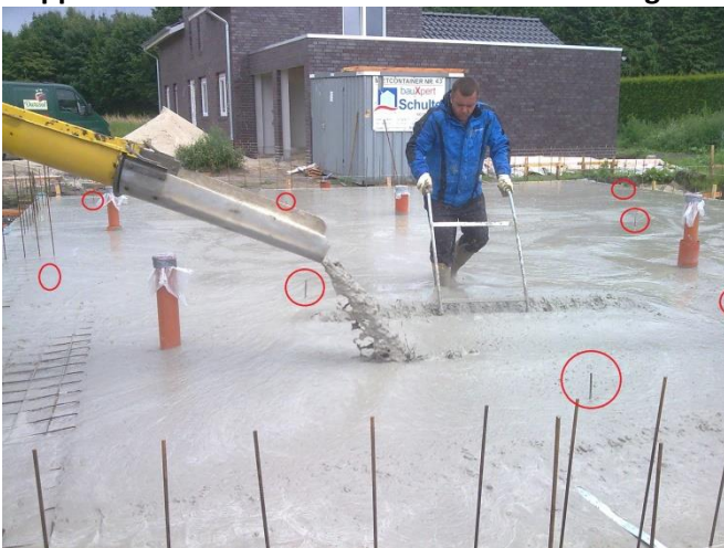
Der F6- Stahlfaserbeton wird nicht per Flaschenrüttler, sondern lediglich mit einer Schwabbelstange bewegt und zur Selbstnivellierung angeregt wird.
