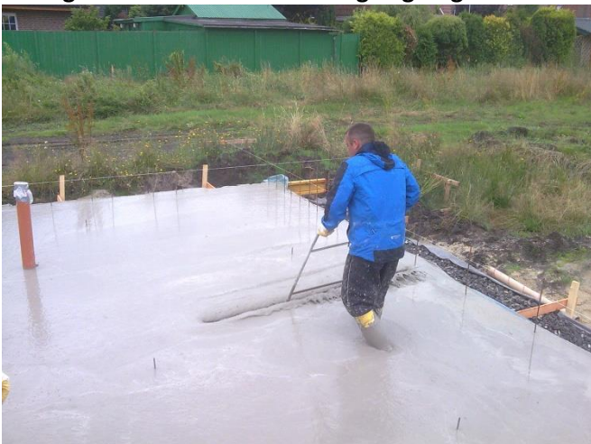
Der F6- Stahlfaserbeton wird nicht per Flaschenrüttler, sondern lediglich mit einer Schwabbelstange bewegt und zur Selbstnivellierung angeregt wird.
