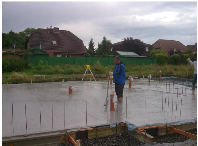
Der Stahlfaser- Fließbeton F6 verteilt sich fast ganz allein auf die gewünschte Bauhöhe. Organisierte Bauhelfer stehen sich die Füße in den Bauch.
