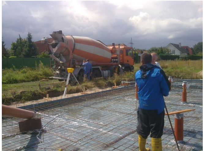
Vor der Betonung sind die Höhenpunkte innerhalb der Betonungefläche auszurichten.
