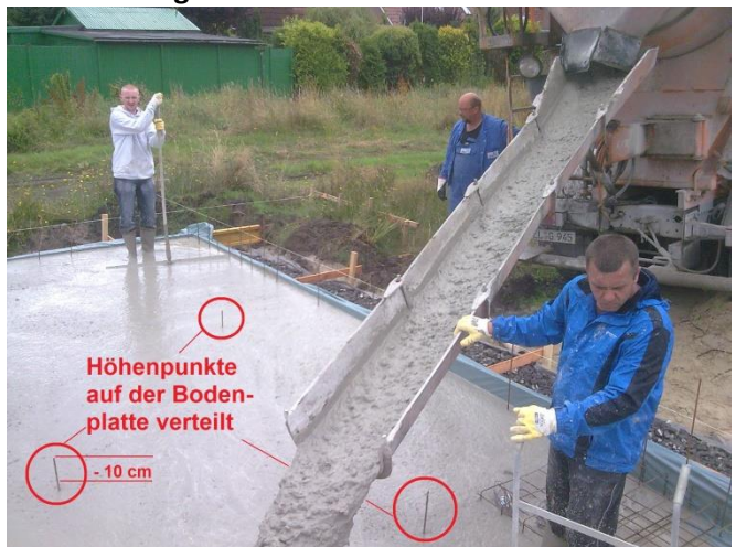
Der Stahlfaser- Fließbeton F6 verteilt sich fast ganz allein auf die gewünschte Bauhöhe. Organisierte Bauhelfer stehen sich die Füße in den Bauch.
