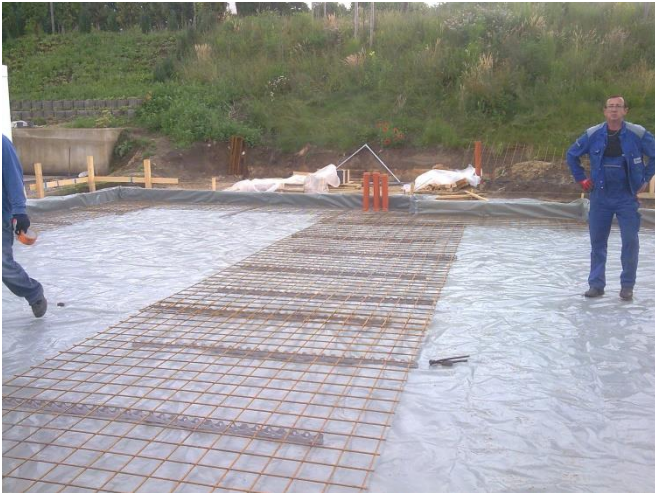
Einbau von Baustahlzuglagen, z.B. für die Gebäude – Doppel- Mittelwand und für die Randbewehrung.
