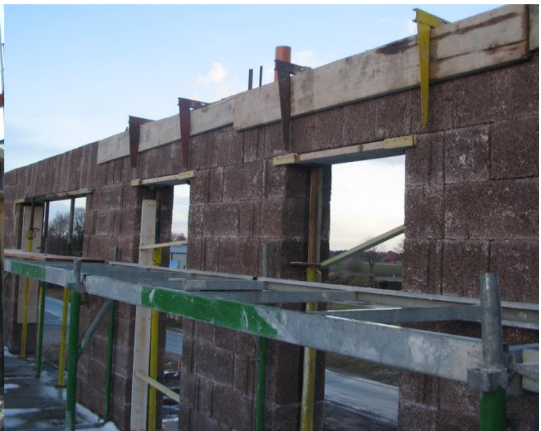
Gewerbekbau aus halbmeter Normalmalsteinen und Universalsteinen auch zur Sturzschalen-erstellung inkl. Wärmedämmung sehr gut geeignet ( Hersteller Nr. 4 )
