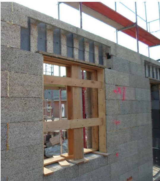
... steinen, spart keine Bauzeit ein sondern sorgt für unnötige Zusatzarbeiten. ( Hersteller Nr. 1 + 2 + 3 )
