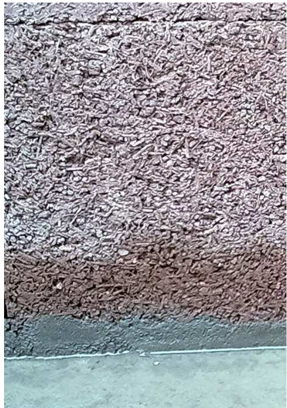
7 – 10 cm kapillare Saugwirkung des Holzbeton
