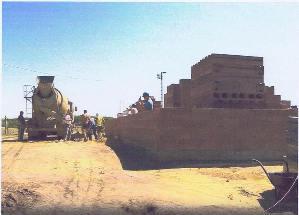
Eine wichtige Entscheidung bezüglich der Ausführung ist, ob wir die Durisol-Wand geschosshoch oder abschnittsweise betonieren wollen. Diese Entscheidung bestimmt auch die zu **verwendende konkrete Technologie**.
