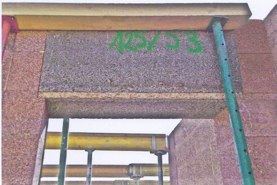
halbe Stein ist. Man muss immer darauf achten, dass die richtigen Hohlräume für das vertikale und horizontale Beton- oder Stahlbetongefüge in der Schalung entstehen. Die Elemente können trocken oder zusammengeklebt verlegt werden. Die Versetzanleitung der Leier Mauersteine informiert ausführlich und mit detaillierten Abbildungen über die Ausbildung von Wandenden, Wandecken und anderen Wandelementen.
