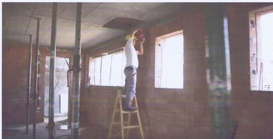
getrennten Strängen bzw. zu der Wandkonstruktion befestigt von außen zu leiten. Da die Holzbetonschale keine Lasten trägt, müssen sogar leichte Armaturen in den Betonkern gedübelt an der Wandkonstruktion befestigt werden.
