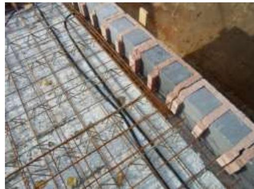
Deckenrand- Überstand über der Decke entsteht genügend Platz für den Zementmörtel als Ausgleichsschicht zum Anlegen der nächsten Geschossschicht ohne in der Fassadenwand eine Mörtelfuge zu verursachen. **Fugenfreier Wandaufbau.**
