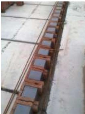
Wir bieten mit der Deckenranderstellung aus DSS37,5- Normalsteinen gegenüber dem Wandaufbau aus dem gleichen Stein annähernd gleiche Dämmwerte weil lediglich die Innenplatte vom Stein abgetrennt wird. Die Steinhöhe von 25 cm braucht nicht der Deckenhöhe z.B. 20 cm angepasst werden. Man bildet Innenseitig ein Deckenauflegerpolster von z.B. 3 cm unterhalb der Decke und befestigt den 25 cm hohen Deckenrandstein auf dem unteren Mauerwerk mittels PU- Kleber. Mit den 2 cm
