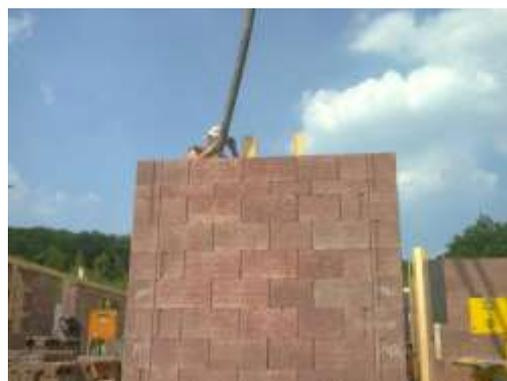
Durisol ist überwiegend ein Naturdämmstoff als Schalung, Beton das tragende Bauteil als Gitter darin. Erst werden die
