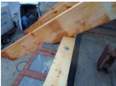
Links: Standard- Dachstuhlanschluss am Holzspanstein-Drempel / Kniestock. **Auch hier Bauperfektion**, weil Wärmedämmung und Statik im Bausystem vereint sind.
