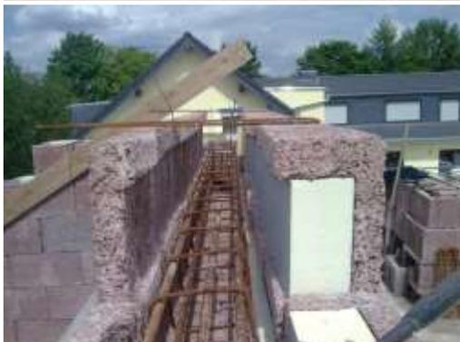
Links: Baustahlkörbe werden mit Abstandhaltern von der Holzspannschalung entfernt oder, wie hier im Bild zu sehen ist, mit Bindedraht angehoben.
