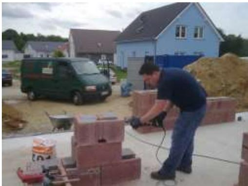
Links: Für den guten Betonfluss werden alle notwendigen Durchlässe per E-Säge in die Sondersteine eingeschnitten.
