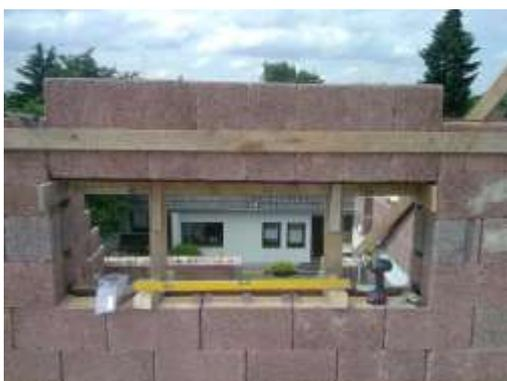
Rechts: Die U- Schalen werden bauseits aus den Universalsteinen gefertigt. Aus einem Universalstein entstehen eine oder zwei 25 cm hohe U-Schalen welche übrigens **ohne Aufpreis** im normalen Quadratmeter Steinpreis enthalten sind.
