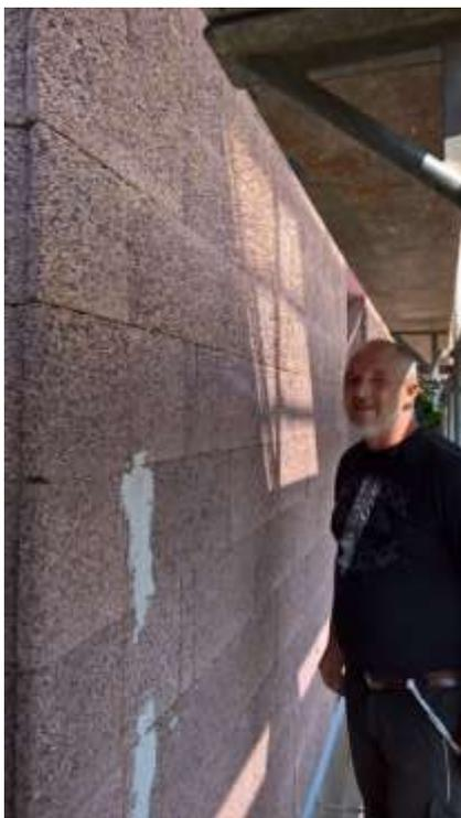
Sollte sich einmal während dem Betonagevorgang die Wand unmerklich, meist durch Stöße während der Wandfüllung verschieben, so nutzen Bauprofi's im nachhinein einen Stahlschrubbel ( siehe rechts ) und raspeln damit die überstehenden Wandfläche so lange bis die Wand wieder lotrecht zu stehen scheint. Die innenseitige Wandfläche benötigt entsprechend einen dickeren Putzaufbau als Ausgleich.
