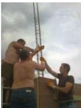
Links: Einbau der Stützenbewehrung in die vorbereitete Holzbetonwand o. Kran.
