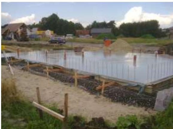
Links: fertige Bodenplatte mit Anschlussbewehrung für die Durisol- Holzbeton-Schalungssteine.
