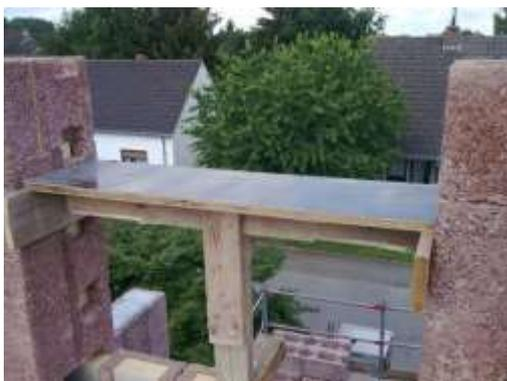
Wärmedämmte und Stahlbewehrte Tür – oder Fensterstürze werden aus den mitgelieferten Universalsteinen hergestellt. Die Bauhöhe kann zwischen 25 - 50 cm variieren, Anschlussbewehrungen laufen ca. 20 cm oder nach statischen Vorgaben in den angrenzenden Wandbereichen ein.
