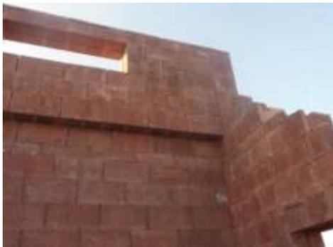
Links: Alles aus einem Guss, trag. DG-Mittelwand, Giebelwand und Firstwand vollständig in Wärmedämmt und alles tragsicher miteinander über ein wandinneres Betongitter verbunden.
