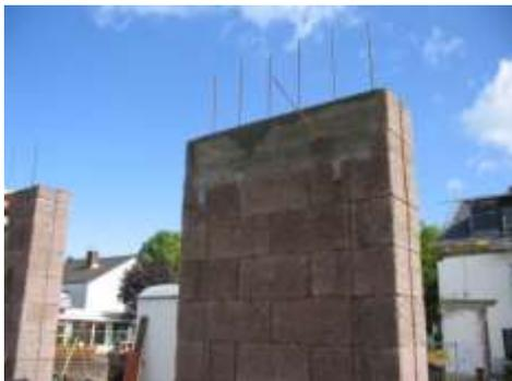
Links: Der 1,50 m breite Wandpfeiler soll einen 10 m langen Betonbalken tragen auf welchem wiederum 60% des Obergeschosses lastet. Die zusätzlichen Lasten werden durch die Verbreiterung des wandinneren Betongitters ermöglicht indem die raumseitige Holzbetonschale zu Gunsten des Betonkerns entfernt wird.
