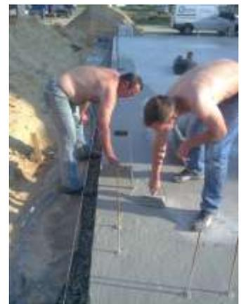
Holzspan- Wände werden ohne Mörtelfugen fugenfrei errichtet. Die erste Steinschicht allerdings wird in Zementmörtel gesetzt um für die Folgeschichten einen gleichmäßigen Wandaufbau durch das einfache Aufstapeln der einzelnen Bausteine zu erreichen. Für die Wanderstellung eignen sich handwerkliche durchschnittlich begabte Baulaien genauso wie kreative Baufachleute. **Allen Bauausführenden gemeinsam sollte der Spaß am erschaffen von Werten sein.**
