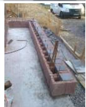
Anlegen der ersten Steinschicht gelingt mit erdfuchten Zementmörtel und einem Fäustel am besten.
