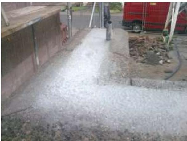
Zum Abschluss wird der Beton geglättet oder wahlweise eine Mauerabdeckung aufgebracht. Leerrohr-Installationen zum Zweck einer Elektroinstallation oder einem weiteren Aufsatz sind in Anstimmung mit dem Tragwerksplaner ebenfalls möglich.
