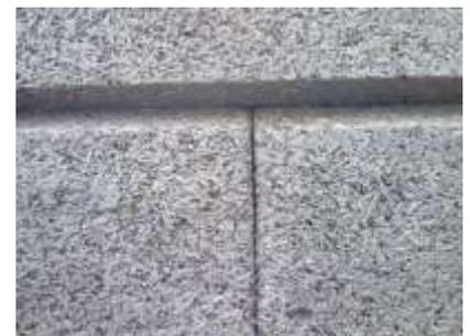
Unmittelbar nach dem Betoniervorgang, oder besser während dessen, sind eventuell vorhandene Betonreste von der LSW- Sichtschale mit einem harten Wasserstrahl zu entfernen. Der lotrechte Wandaufbau ist zu überprüfen und ggf. noch mit einem schweren Gummihammer nachzurichten.
