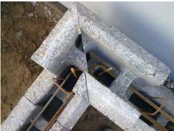
Ist eine Fixierung des Baustahls angeordnet, so liefern wir auf Bestellung verzinkte Stahlkrampen mit geschnittener Spitze um den horizontal eingelegten Baustahl in seiner Position zu fixieren.
