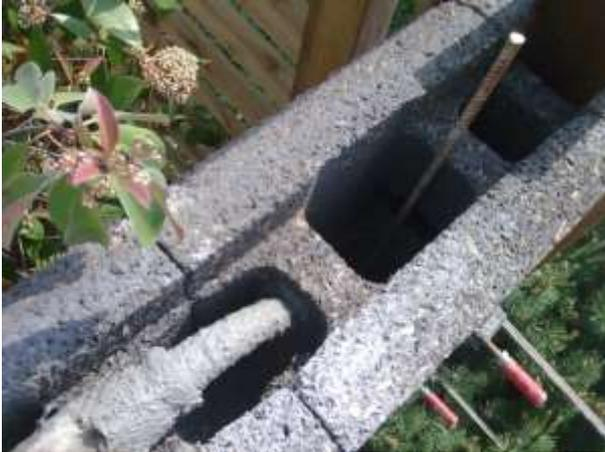
Die Lärmschutzwand kann auf ihre Gesamthöhe oder auch nur bis zu einer Teilhöhe aufgestellt werden bevor sie betoniert wird.
