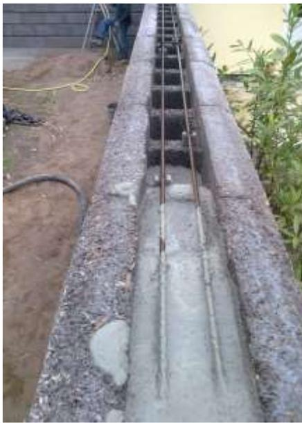
Bewehrungseinlagen werden per Abstandshalter vom Holzspanmantelstein getrennt oder an den Stahlkrampen per Bindedraht befestigt.
