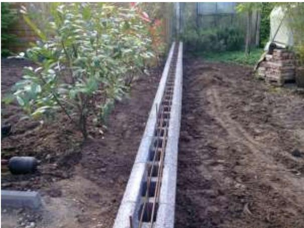
Lärmschutzstein aufweisen, da dieser diffusionsoffen wirkt und somit der Stabstahl korrodieren könnte, wenn er nicht genügend Betonüberdeckung aufweist. Hierzu eignen sich Betonabstandshalter auf dem Verbindungssteg des Steins um den Baustahl mit Beton zu ummanteln.
