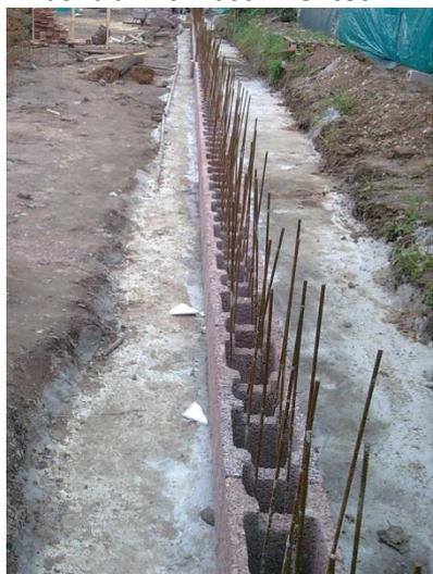
4. Erste Steinreihe mit Anschlussbewehrung exakt ausrichten
