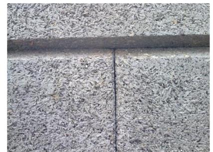
Unmittelbar nach dem Betonagevorgang, oder besser während dessen, sind eventuell vorhandene Betonreste von der LSW- Sichtschale mit einem harten Wasserstrahl zu entfernen. Der lotrechte Wandaufbau ist zu überprüfen und ggf. noch mit einem schweren Gummihammer nachzurichten.
