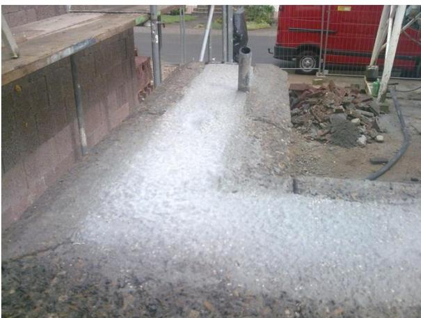
Zum Abschluss wird der Beton geglättet oder wahlweise eine Mauerabdeckung aufgebracht. Leerrohr-Installationen zum Zweck einer Elektroinstallation oder einem weiteren Aufsatz sind in Abstimmung mit dem Tragwerksplaner ebenfalls möglich.
