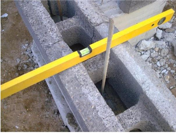
Das Anlegen der ersten Steinreihe sollte möglichst sorgsam und maßgenau erfolgen da die weiteren Steinreihen nicht mehr in Mörtel, sondern nur noch trocken im Läuferverband gestapelt, erfolgt.
