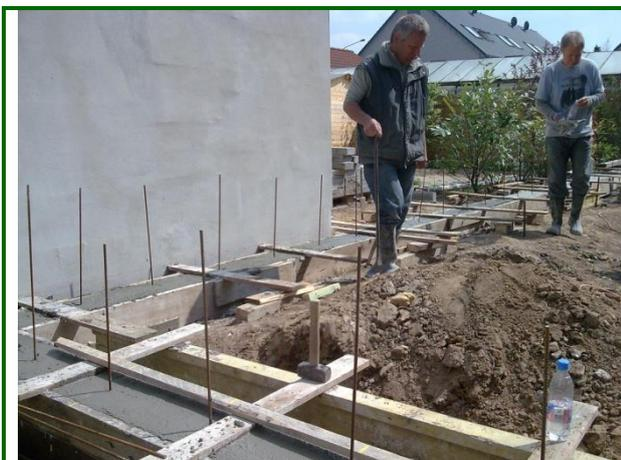
Die Streifenfundamente werden nach statischen Vorgaben mit einer Anschlussbewehrung hergestellt.
