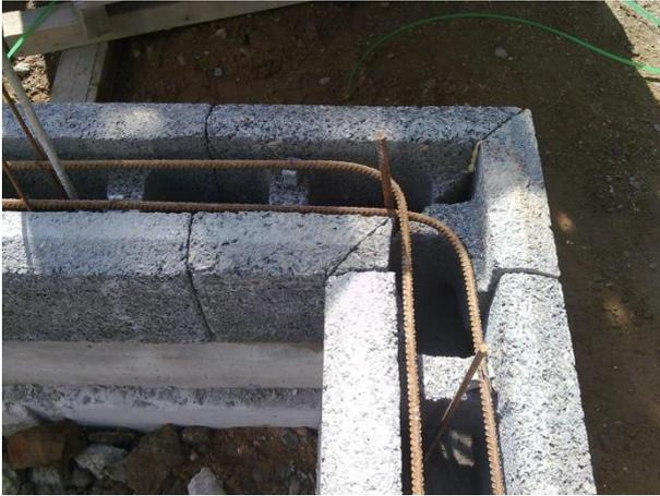
Nach dem Erstellen der ersten Steinschicht wird die erste waagerechte Stahlbewehrungslage in den Wandverfüllraum eingelegt. In den Ecken werden die Winkleisen über Kreuz ( siehe Bild ) eingelegt. Wenn aus statischer Sicht nicht anders vorgeschrieben, werden zwei 8 mm dicke Stabstahllängen fachgerecht, d.h. mit ca. 60 cm Überdeckung mit dem Folgestabstahl der Horizontalbewehrung eingelegt und mit Bindedraht miteinander verbunden.
