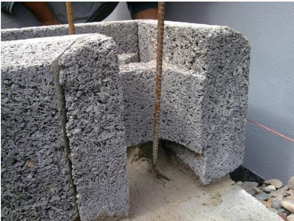
Achten Sie beim Anlegen der ersten Steinschicht auf die Anschlussbewehrung welche sich aus dem Fundament kommend in Augenhöhe befindet!
