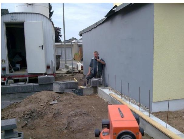
Die erste Steinreihe wird komplett in einem Mörtelbett aus Zementmörtel maßgenau angelegt. Hierzu ist vorab das Höhenmaß des Fundamentes zu überprüfen. Der höchste Punkt des Streifenfundamentes gibt, sofern das Unterschiedsmaß noch vertretbar ist, die spätere Steinhöhe plus Mörtelbett vor.
