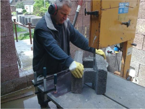
Ecksteine lassen sich leicht aus den Normalsteinen in jedem beliebigen Winkel herstellen. Mit der Hilfe einer Bandsäge, der Sägertisch sollte im Winkel zum Sägeblatt 90° aufweisen um die notwendige Passgenauigkeit zu erhalten, lassen sich die Lärmschutzsteine einfach zuschneiden.
