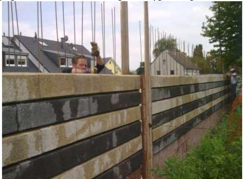
16. Baustahljustierung nach dem ersten Betoniervorgang
