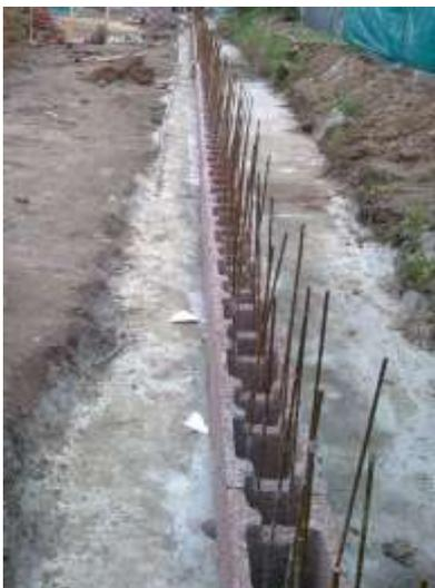
4. Erste Steinreihe mit Anschlussbewehrung exakt ausrichten
